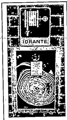
Per gli **IMPIANTI SEMI-FISSI** il sistema comprende una *rete idrica fissa di alimentazione*, con portata adeguata, e sistemi di erogazione ad essa collegabili costituiti da *cassette di idranti, naspi rotanti e manichette con lancia*.
